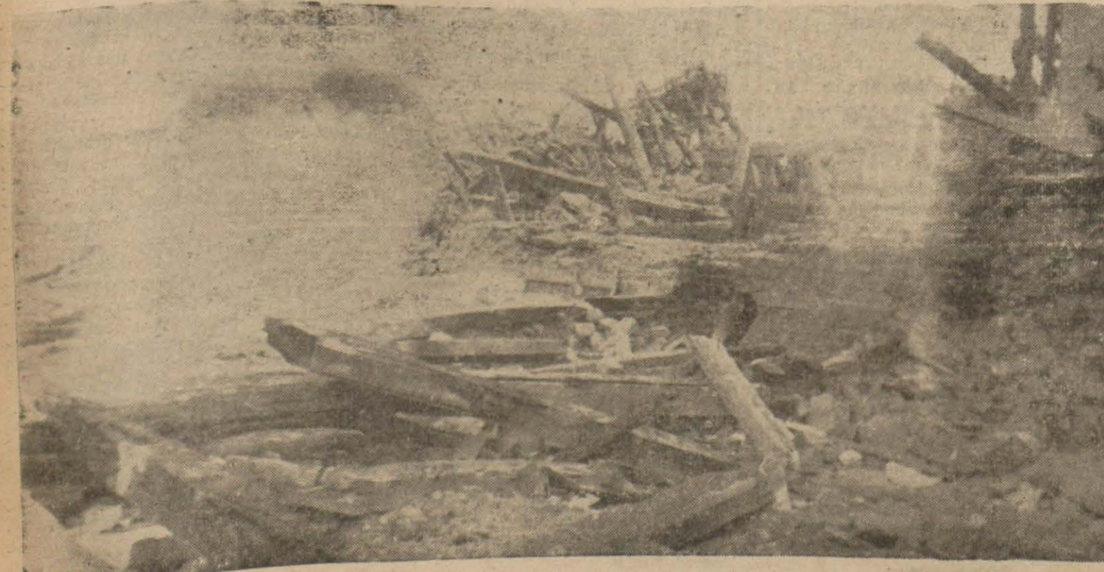
Bedbaht Erzincanın enkaz haline gelen bir mahallesi
