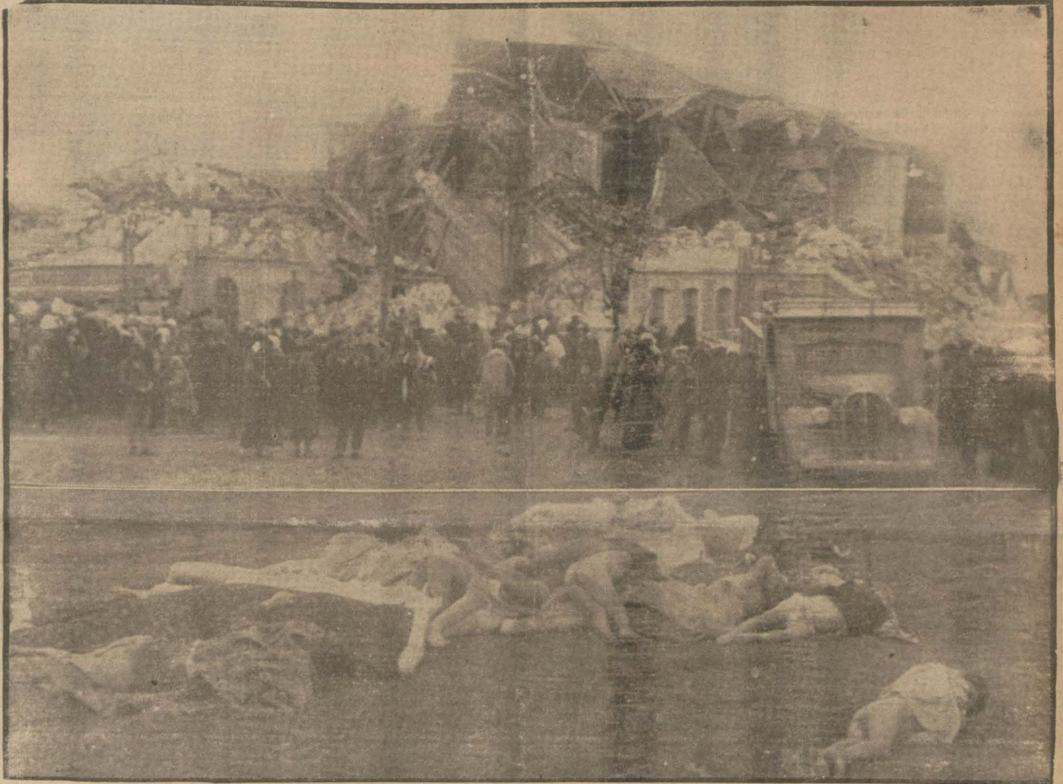
Felek, Erzincanı böyle vurdu... [Yukarıda şehir, aşağıda bir kısım kurbanlar]
